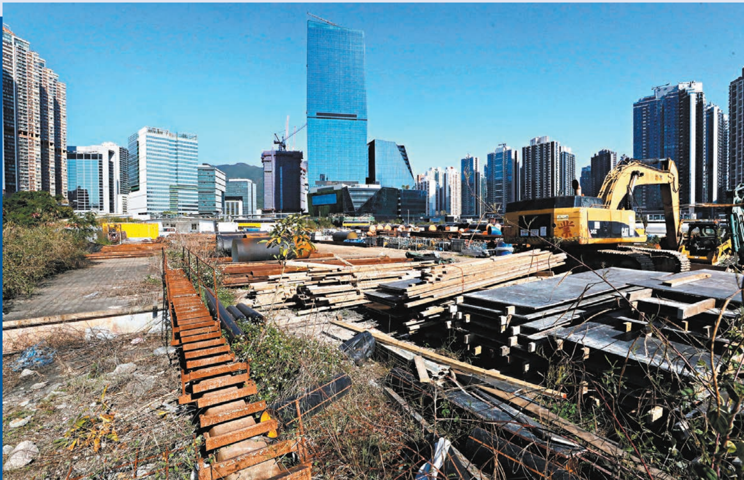
◆房屋局局長何永賢表明，「簡約公屋」項目對啟德以至九龍東發展定位並無影響。圖為啟德世運道「簡約公屋」選址。
