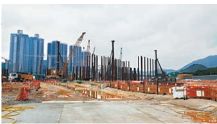
◆ 沈迎彥於2016年4月拍攝蓮塘/香園圍口岸建設場景，圖中高樓為深圳一側。 受訪者供圖
