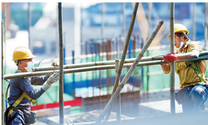
◆有89%受訪公司稱經營最大挑戰是人力資源不足。圖為建築工人搭建棚架。資料圖片
