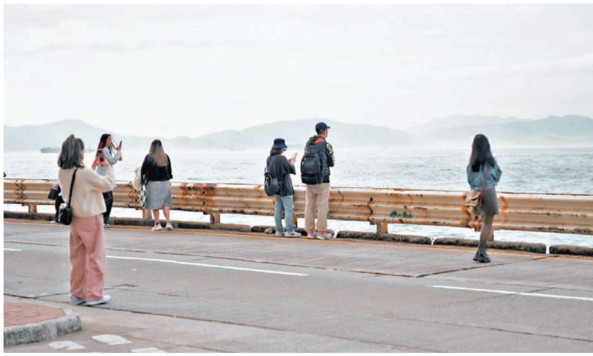
◆堅尼地城新海旁面向維港的路段為馬路，未能填海拓空間，人車爭路，影響遊人欣賞日落時的體驗。
