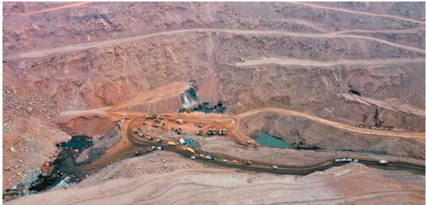
◆2月23日，救援車輛在內蒙古自治區阿拉善盟阿拉善左旗新井煤業有限公司露天煤礦坍塌事故現場作業。 新華社
