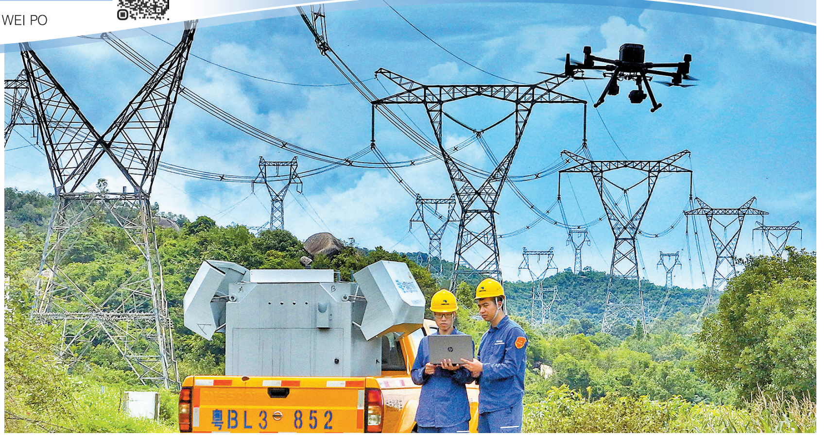
科技手段助力對港供電。圖為南方電網深圳供電局輸電線路運維人員利用車載移動機巢搭載無人機群對400千伏核深線進行特巡特維。香港文匯報深圳傳真
