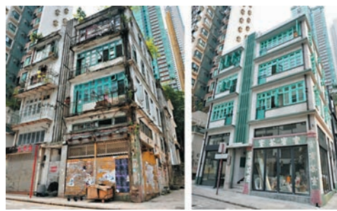
◆士丹頓街88號至90號修復後(右圖)已回復唐樓昔日面貌，保留了木製窗戶、樓梯和外牆飾面等建築特徵元素。
