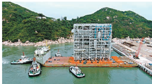
◆石鼓洲焚化爐巨型設備組件抵港。
