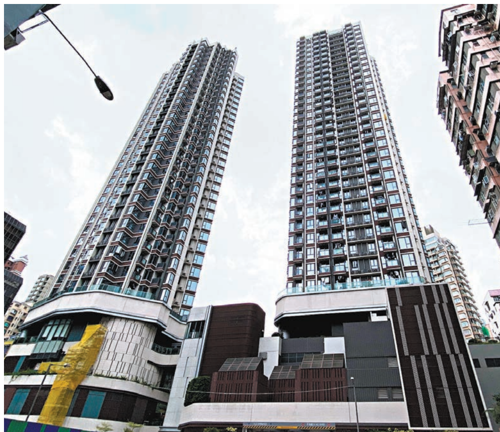
◆市建局首置項目煥然懿居二期將作為預防性維修試點。圖為煥然懿居。
