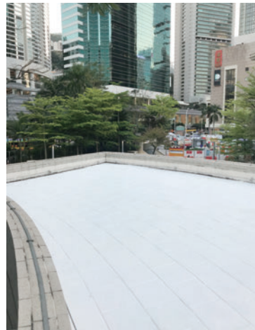
塗上「無電製冷技術」物料的天台,可大幅反射熱力,減少大廈製冷的能源消耗。
