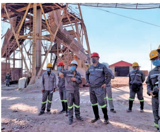
◆ 施工現場考察
