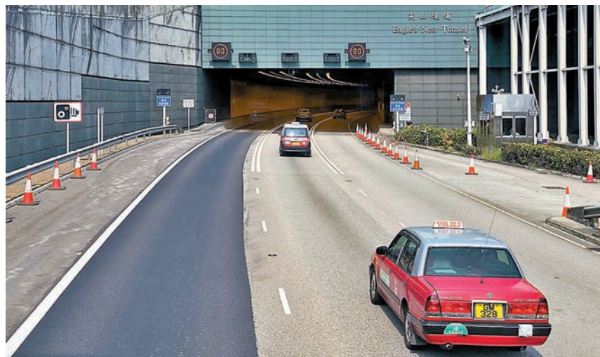
◆「易通行」措施將如期在下月7日上午5時開始，正式在青沙管制區（即尖山隧道、沙田嶺隧道和大圍隧道）實施。圖為尖山隧道長沙灣入口。資料圖片
