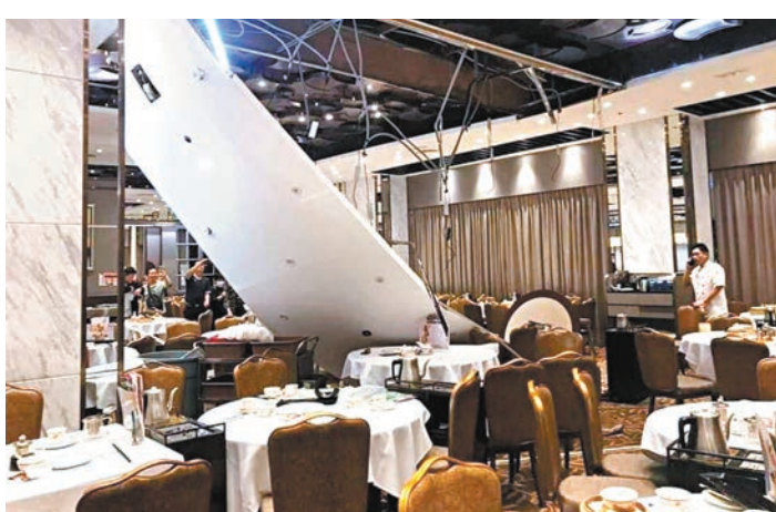
塌下的假天花殘骸包括大堆石屎及生鏽鋼筋。讀者提供
