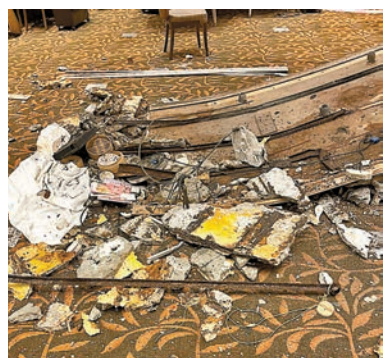
塌下的假天花殘骸包括大堆石屎及生鏽鋼筋。讀者提供
