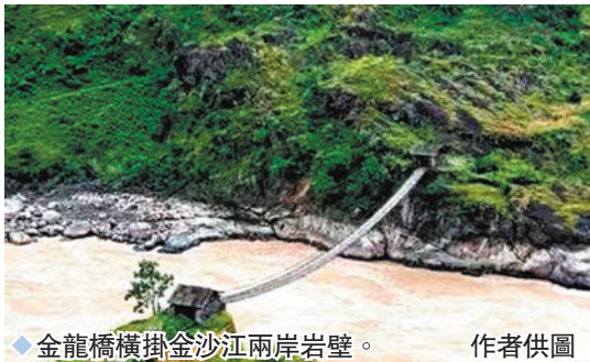
◆金龍橋橫掛金沙江兩岸岩壁。作者供圖
