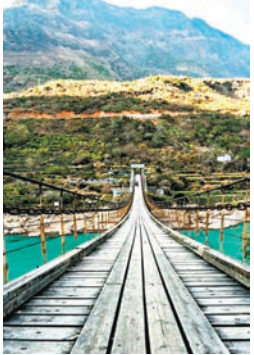
◆金龍橋鐵鏈上的木板橋面。作者供圖
