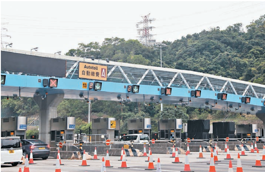
◆青沙管制區一帶會由5月6日晚上11時起，分階段實施臨時交通安排，以關閉收費亭及更改標誌等。
