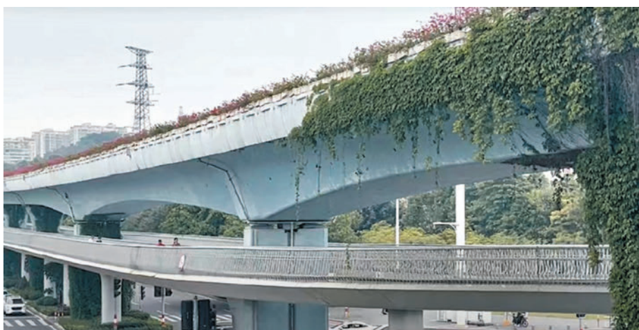
空中單車徑及步道是借助捷運系統的高架結構，為市民提供健身環境和城市景點。圖為廈門步道。
