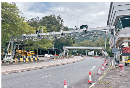
◆獅子山隧道將於下週日(28日)起實施「易通行」。圖為於獅子山隧道往九龍方向的「易通行」收費設備(龍門架)。
