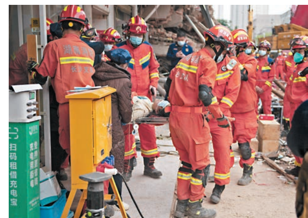
2022年5月1日拍攝的湖南長沙居民自建房倒塌事故救援現場。
