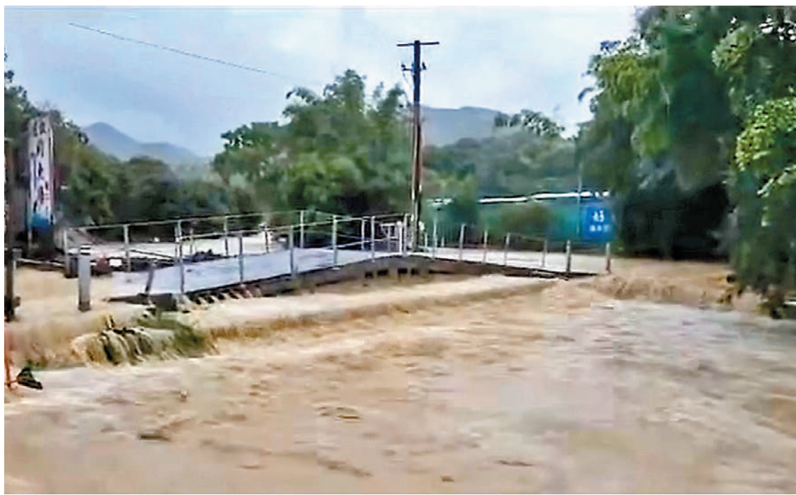
◆鴨仔坑在大雨下渠道堵塞，洪水湧出蓋過路面。
