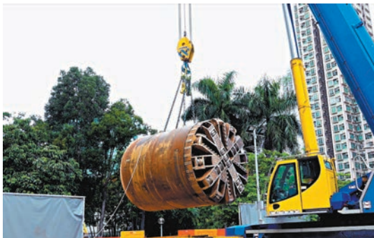
◆工程團隊選擇了水管推頂法進行無坑敷管。水務署供圖
