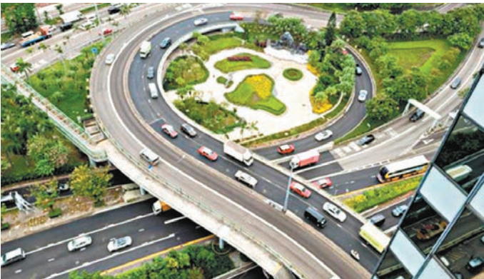
◆路政署於去年底分階段重鋪堅拿道天橋大部分瀝青路面。圖為該天橋南行線瀝青路面重鋪後情況。
