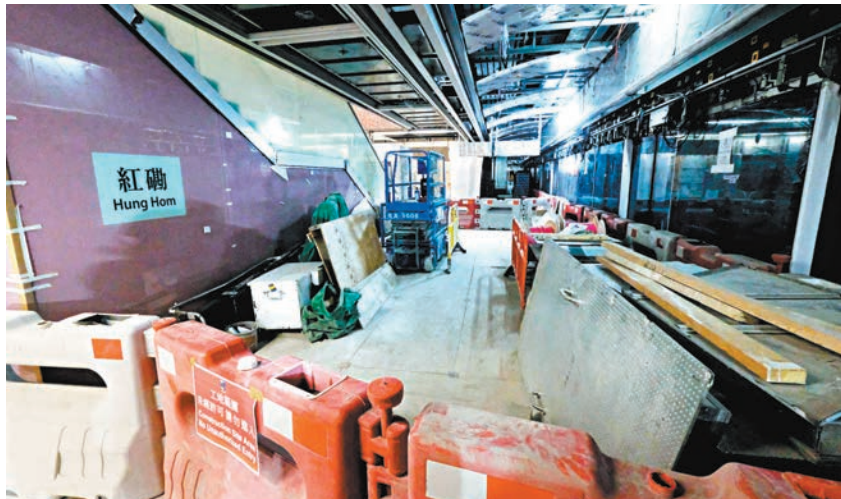
◆律政司已經就港鐵沙中線問題案向裁判法院提出刑罰覆核。圖為興建中的沙中線紅磡站工地。資料圖片
