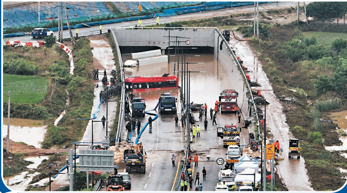
「貢坪2號」地下車道被洪水淹沒，巴士嚴重損毀。美聯社
