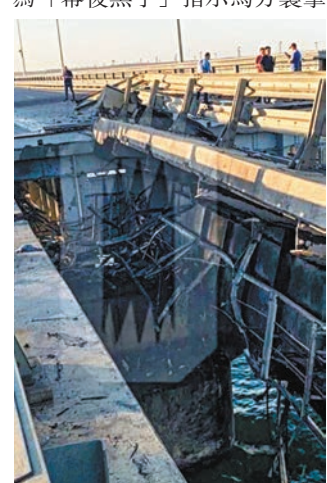
橋身被毀位置鋼筋外露。網上圖片
