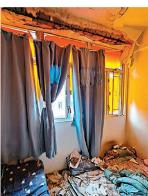
現場所見，房間窗口對上約3米長天花石屎剝落露出生銹鋼筋，地上床褥則滿布石屎碎塊。
