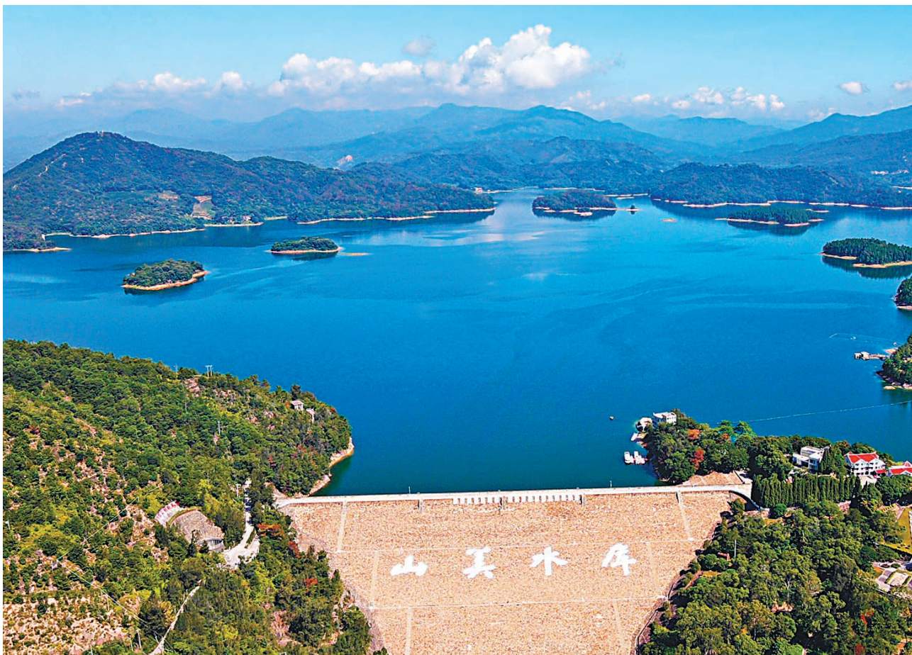
◆金門供水工程水源地——泉州山美水庫。
