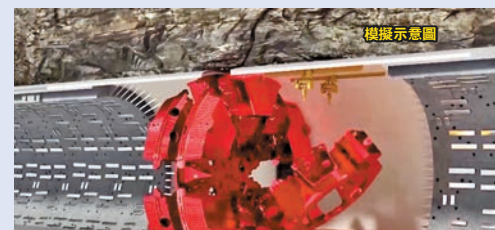
兩台盾構機分別從寧波和舟山方向向海底掘進（模擬示意圖），5層樓高的兩台盾構機海中對接時，精度要求誤差不超過2厘米。網上圖片
