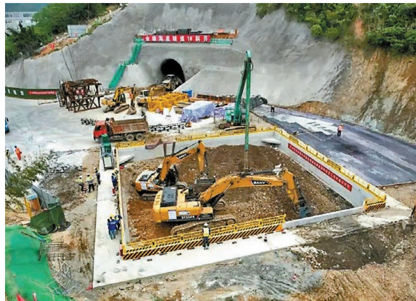
金塘海底隧道盾構井施工現場。
