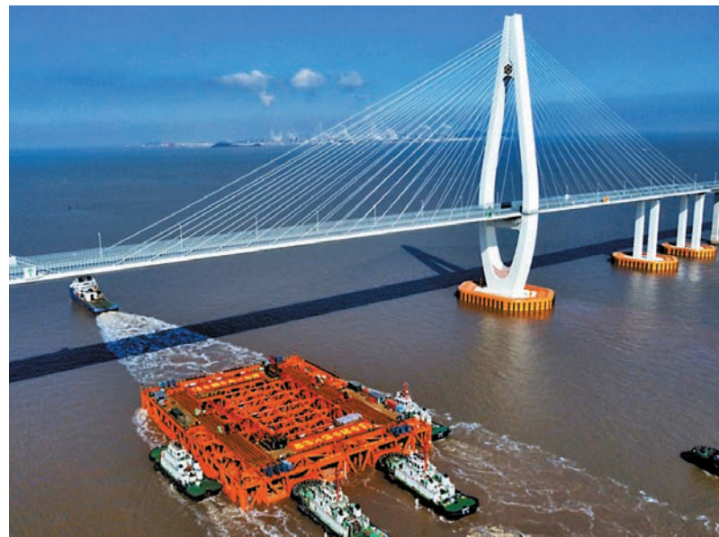
全球最大橋墩鑽孔平台通過舟岱大橋主通航孔。香港文匯報浙江傳真
