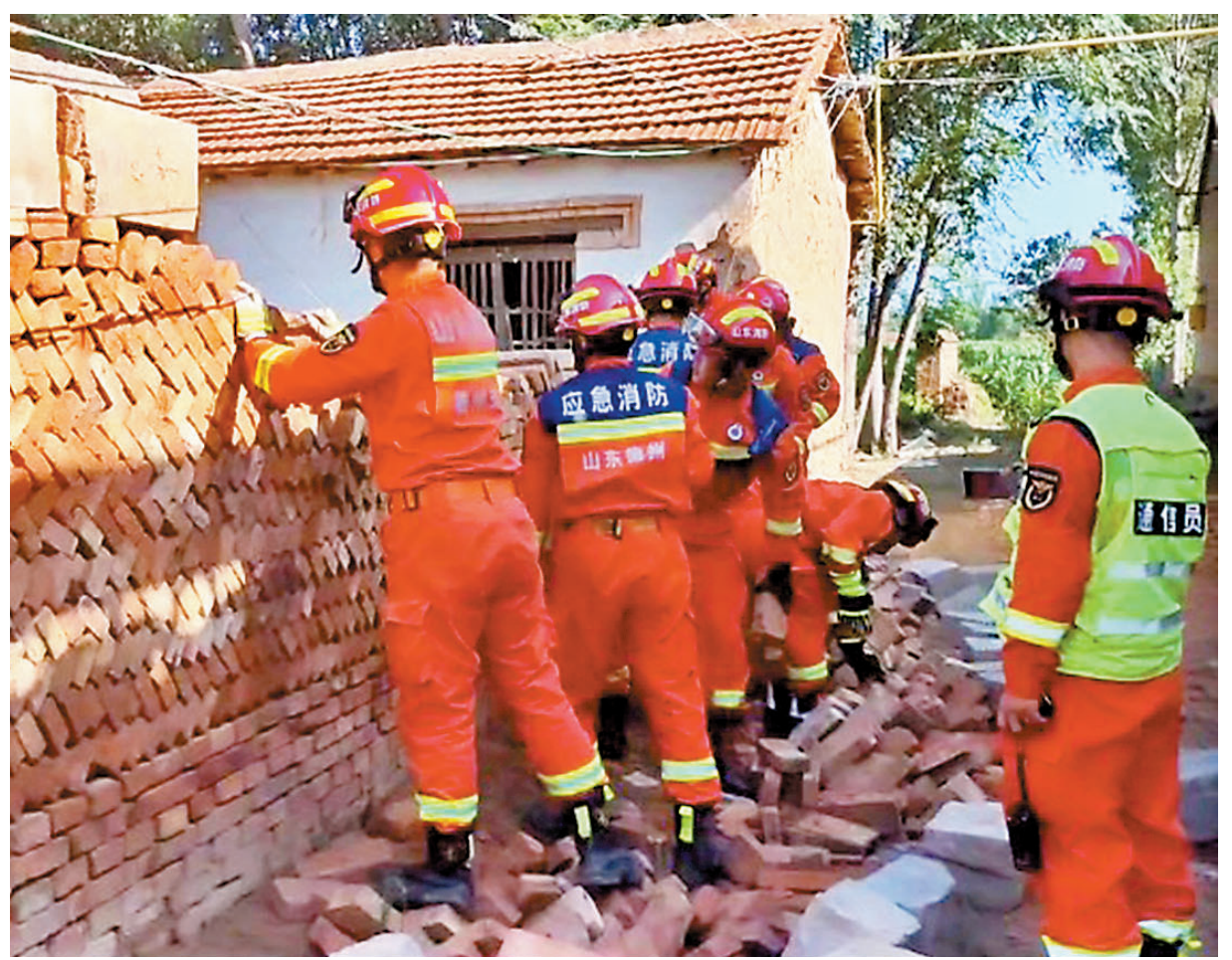
◆山東省德州市消防救援支隊在王打卦鎮張莊村幫助村民修整房屋。
