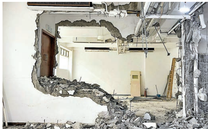
粉嶺中心某地舖進行裝修工程，疑使用風炮機拆除非結構牆，令停車場出現裂縫，劉國勳團隊成員到場跟進。
