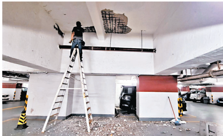
◆北角健威坊停車場天花板有石屎剝落擊中一輛七人車後，工人到場維修，可見露出生鏽鋼筋。
