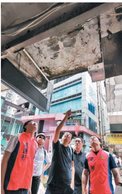
◆梁熙聯同香港驗樓師學會快測50幢港島東舊樓。
