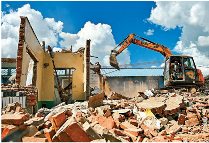
◆8月16日，工作人員對吉林舒蘭市開原鎮模範村的受損房屋進行拆除重建工作。新華社
