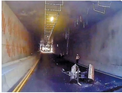
◆肇事夾斗車的吊臂在隧道內連環掃毀約百米頂燈及防撞架始停下。 短片截圖
