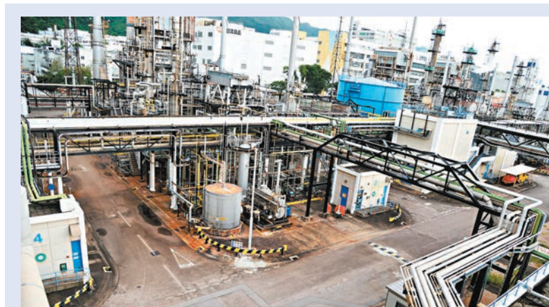
煤氣公司於大埔燃氣生產廠新增一組長達356米的管道，貫通廠內四組燃氣生產爐，輸送餘熱予毗鄰食品廠。
