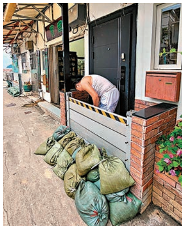
◆鯉魚門居民在門外堆砌沙包和安裝防水閘。 香港文匯報記者鄧偉明攝
