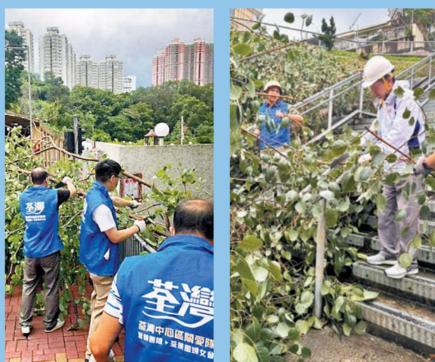
◆荃灣區關愛隊清理塌樹。
