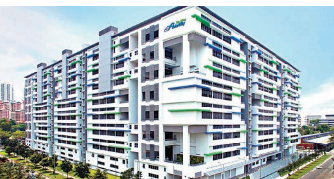
新加坡政府興建Sin Ming AutoCity來安置工場。
