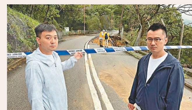
▲梁進到石澳跟進嚴重路陷情況。 梁進 Fb 圖片
