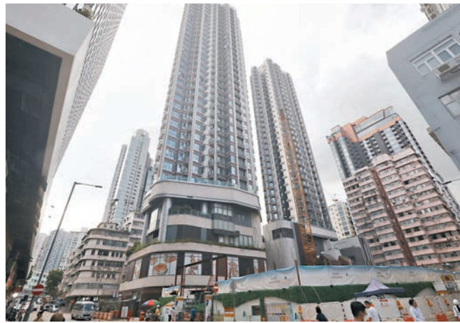
◆市建局將「煥然懿居第三座」首置項目及4幢該局管理的安置大廈試行「升級版」樓宇保養手冊。圖為「煥然懿居第三座」工地。 香港文匯報記者郭木又攝
