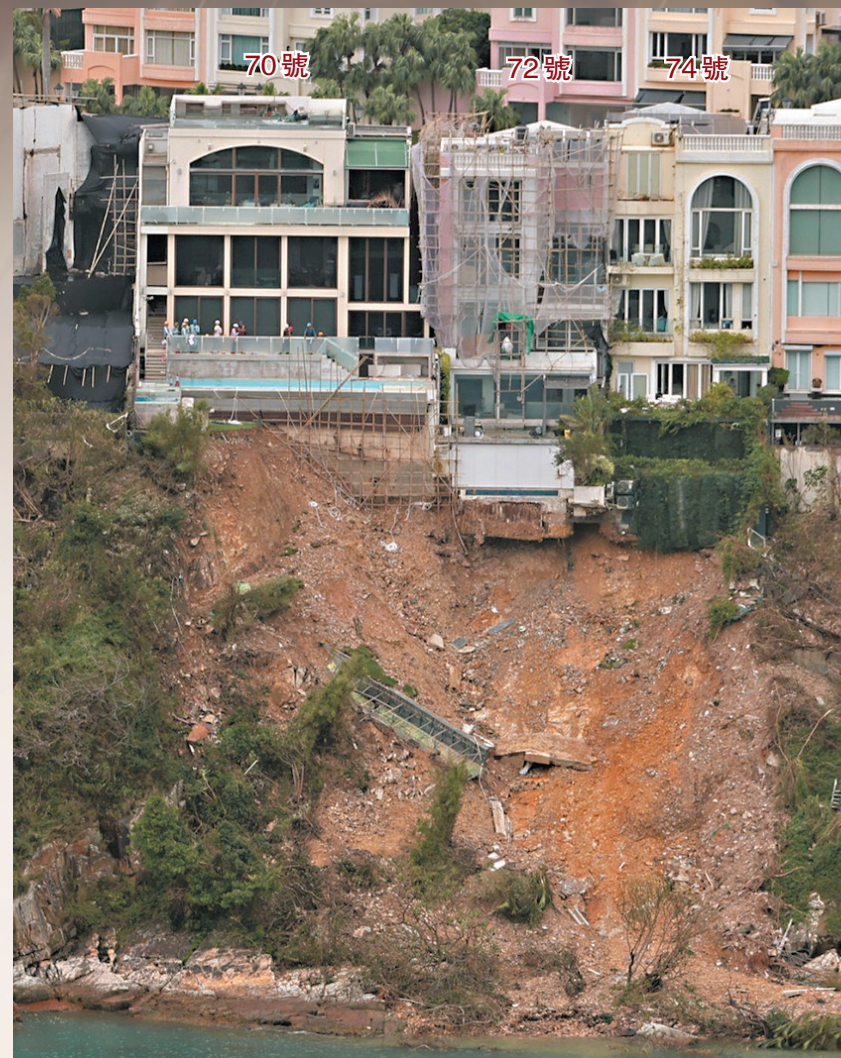
◆政府人員昨日再到紅山半島僭建的70號獨立屋勘察，工人在山坡搭棚準備加固工程。香港文匯報記者鄧偉明攝
