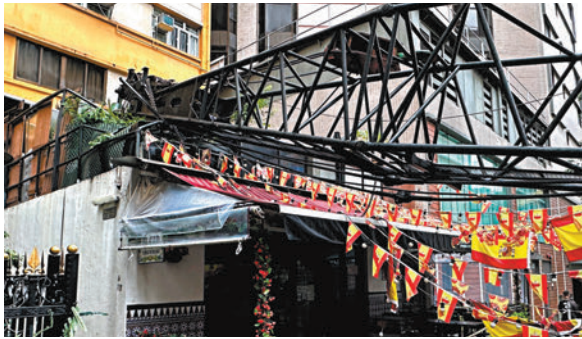
◆26米長的起重機吊臂失去平衡向前塌下，壓毀諾士佛臺的酒吧簷篷和平台花園。
