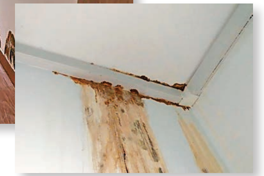
▶▶「恒莆新苑」有單位漏水，地面出現水跡，電線槽也有銹跡。網上圖片
