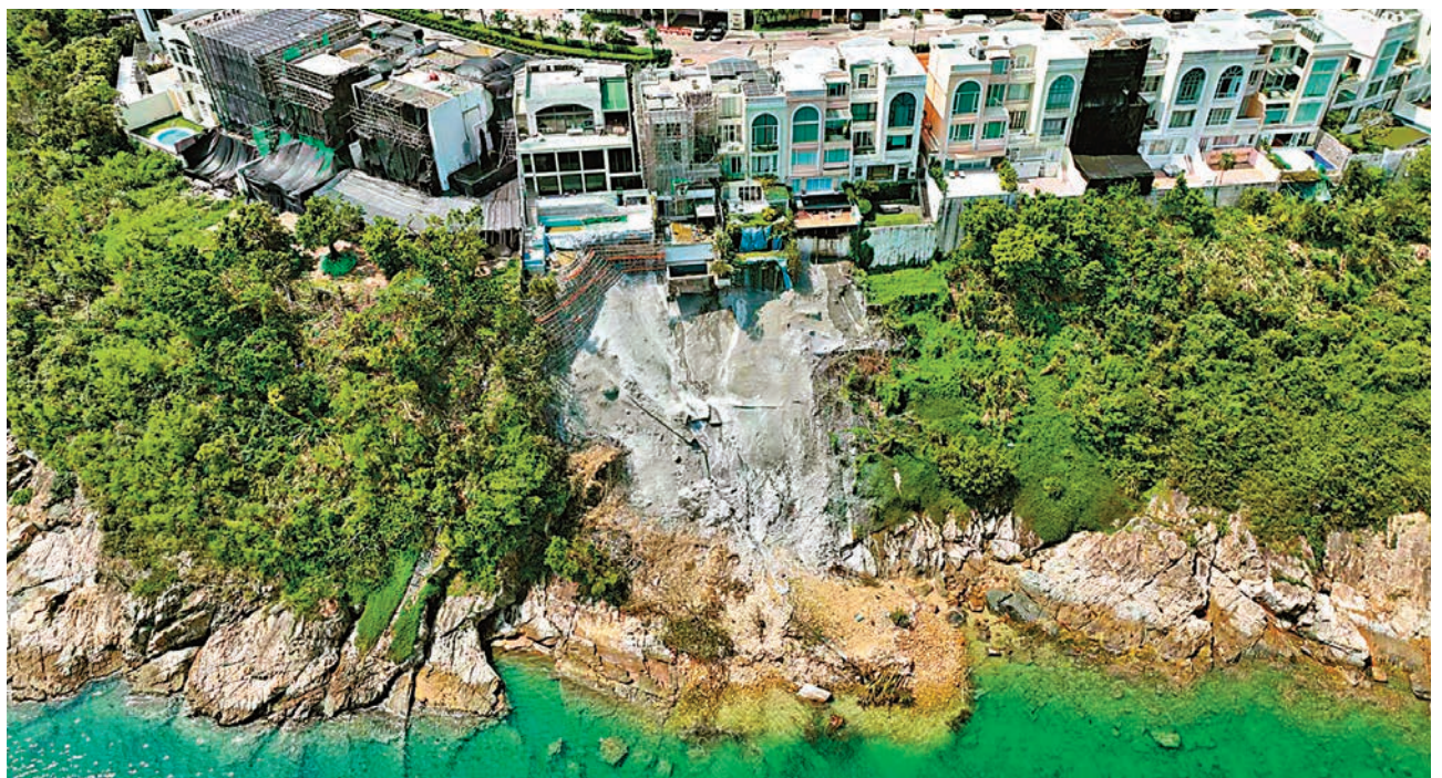
◆在部分紅山半島獨立屋外，一些曾發生山泥傾瀉的斜坡已進行修葺。香港文匯報記者 張得民攝
