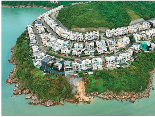
◆紅山半島被揭70幢臨海獨立屋涉嫌佔官地及僭建。資料圖片
