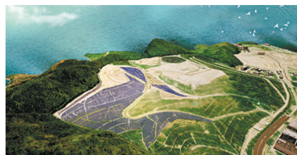
◆擬建於新界東南堆填區的太陽能板發電系統。
