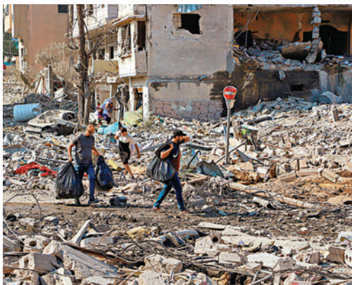
◆加沙城部分建築已成廢墟。
