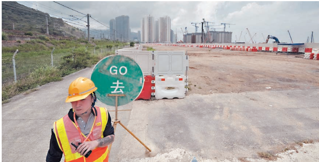
◆東涌東站屬東涌線延伸線一部分，將會位於填海區的東涌新市鎮擴展計劃東面。圖為東涌線延伸線動工典禮於5月份舉行情況。
