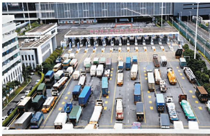
◆今年相繼實施「澳車北上」「港車北上」以來,大橋珠海口岸14次刷新單日車輛通行紀錄。圖為跨境貨車在大橋通關。 香港文匯報珠海傳真
