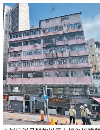
◆屋宇署已開始以無人機為風險較高的樓宇外牆進行勘察。 資料圖片
