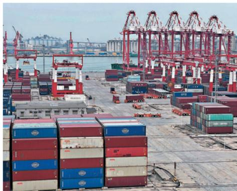
◆員工只需坐在智控大廈的智能眼控中心辦公,就能完成碼頭設備的遠程控制。圖為南沙四期碼頭內,橙色智能導引車將集裝箱運往目標位置。
