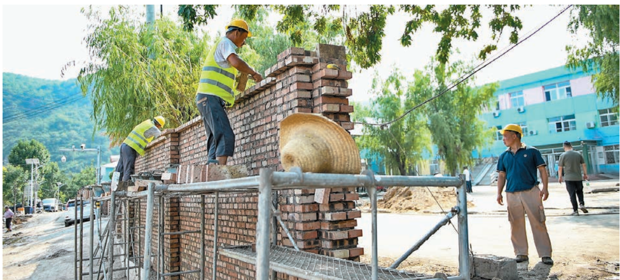
◆ 保證受災學生都能按時開學返校，是黨中央對災後恢復重建提出的明確要求。圖為8月15日，工人在北京市房山區河北鎮中心幼兒園東莊莊子分園重建被洪水沖毀的圍牆。
